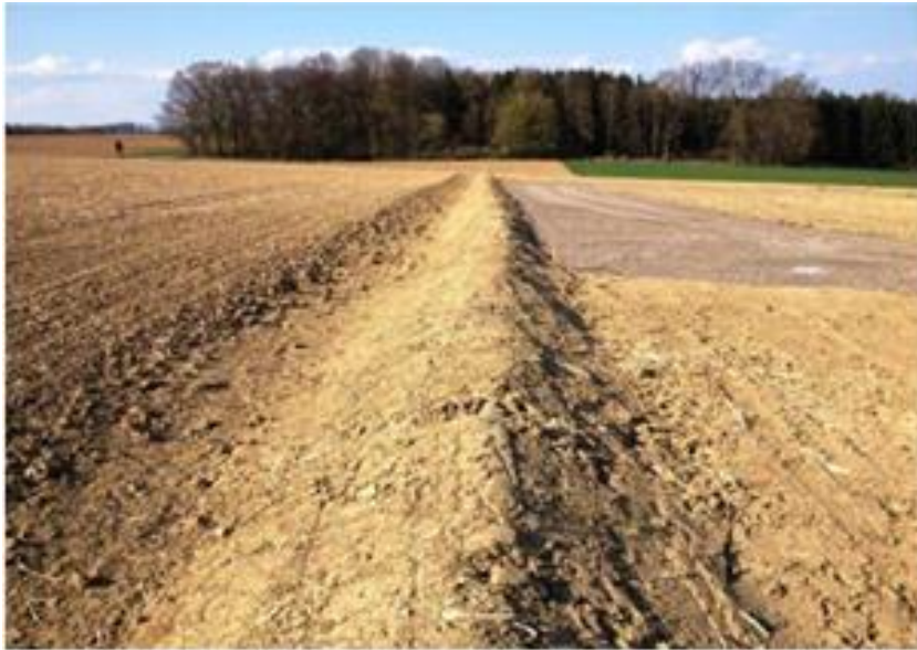
Kleiner Erddamm zur gezielten Umleitung von Hangwässern
