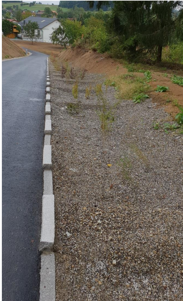
Lineare Retentions- und Versickerungsmaßnahme
