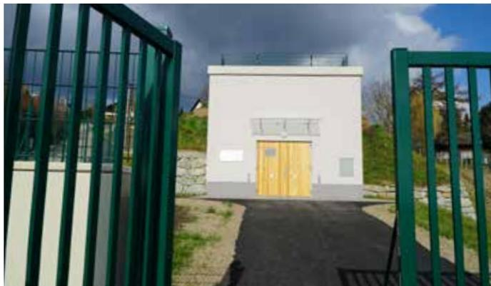
Das neue Pumpwerk in der Käferkreuzgasse verstärkt die Wasserversorgung Klosterneuburgs und pumpt mit einer Gesamtförderleistung von 100.000 Litern pro Stunde kostbares Nass ins Versorgungsgebiet.
