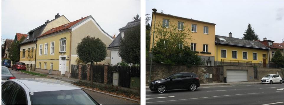
Abbildung 5: Beispiele für Ein- und Zweifamilienhausbebauung in gekuppelter oder geschlossener Bauweise, Quelle: Eigene Aufnahme
