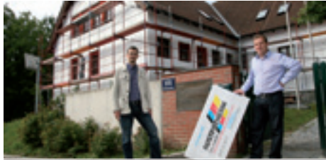
Energieeffizienzstadtrat Mag. Roland Honeder (l.) und Gemeinderat Leopold Spitzbart besuchten die Baustelle und freuten sich über die Wärmedämmmaßnahmen beim Kindergarten am Ölberg.
