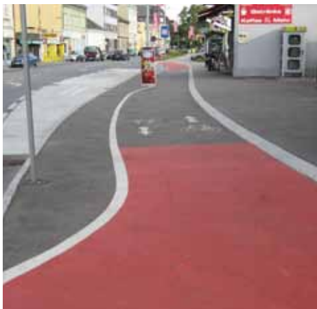
Zur Erhöhung der Verkehrssicherheit wurden auffällige Bodenmarkierungen angebracht.
