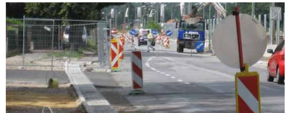
Die Wienerstraße wurde in den Sommermonaten umfangreich saniert.
