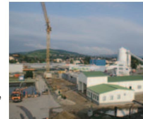
Der Bau der biologischen Kläranlage wurde größtenteils fertig gestellt.
