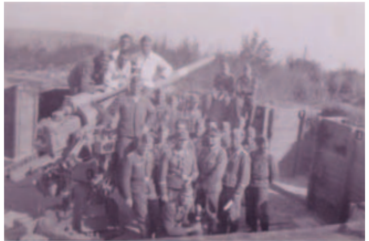
Batterie mit Besatzung (Flak 8.8./37, Geschütz A (Anton) der 1/532) (Foto: Archiv Dr. L. Lechner (ehem. Luftwaffenhelfer bei der 1/532)).
