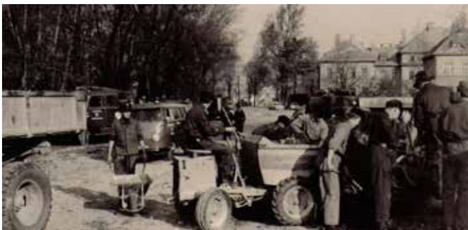
Der Bau des Feuerwehrhauses in Kierling erfolgte in den Jahren 1967-69.
