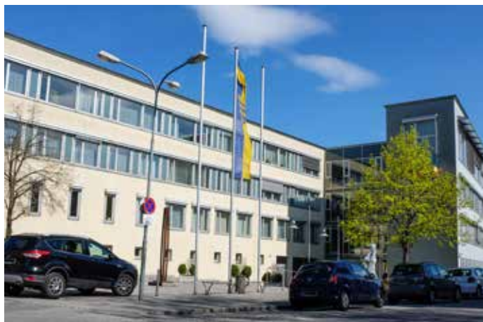
Das BH-Gebäude in der Leopoldstraße könnte in Zukunft der Außenstelle und der Stadtverwaltung Platz bieten. Der Stadtrat beschloss nun, die Kosten zu erheben.
