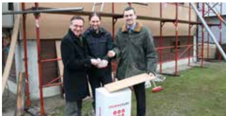
STR Mag. Roland Honeder und STR KR Martin Czerny besuchten gemeinsam mit Referatsleiter Ing. Andreas Fuchshuber die Baustelle und überzeugten sich persönlich von der Qualität der Arbeiten.
